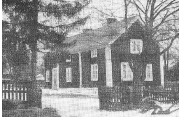
Mangårdsbyggnaden på Krokagården 1945.
